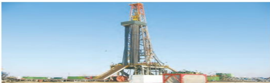
شکل ۱۰- دکل حفاری چاه‌های اکتشافی نفت و گاز
